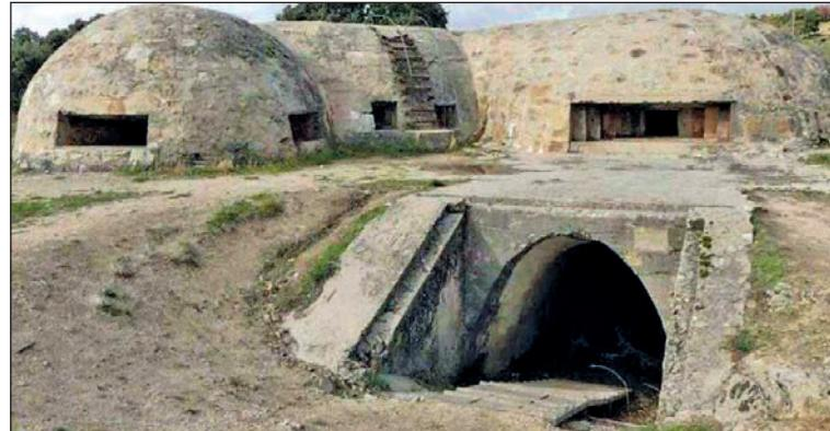
principal a la construcción, desde el cuarto nido, se realiza mediante una rampa descendente desde el exterior a través de un túnel perpendicular a la carretera. El anillo principal cuenta, además, con 12 troneras propias.
