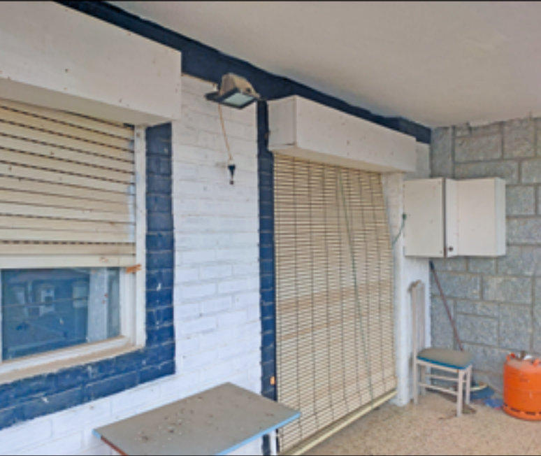
Una de las viviendas del edificio de la calle Alfonso XI, número 21.
